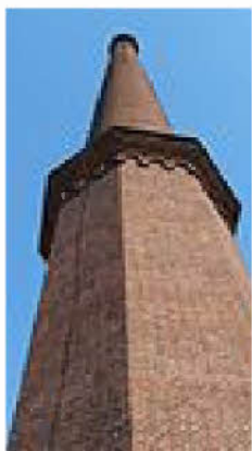
Ciminiera della centrale termica
