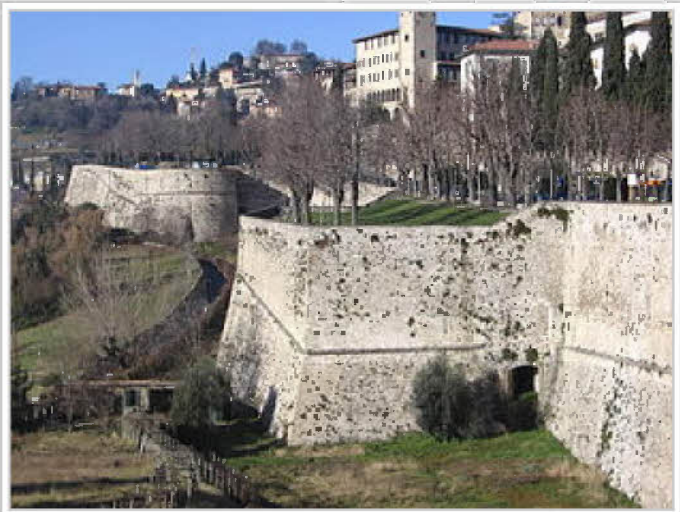
Lato Sud-Ovest delle mura Venete (Piattaforma di Santa Grata e baluardo di San Giovanni)
